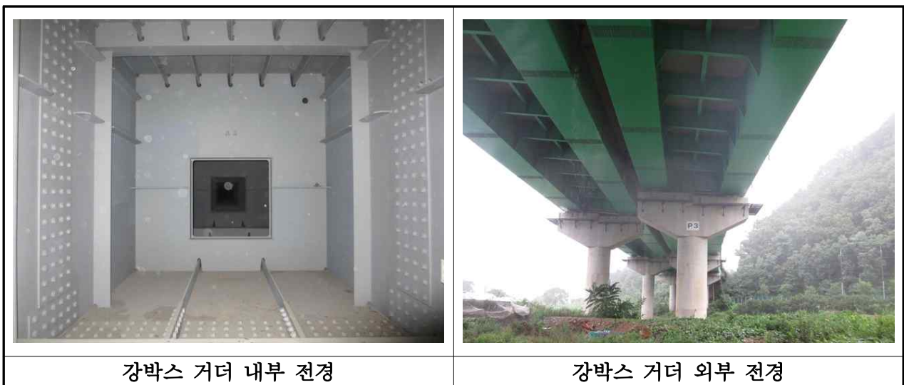
【사진 3.3.3】 강박스 거더 전경(부산)
