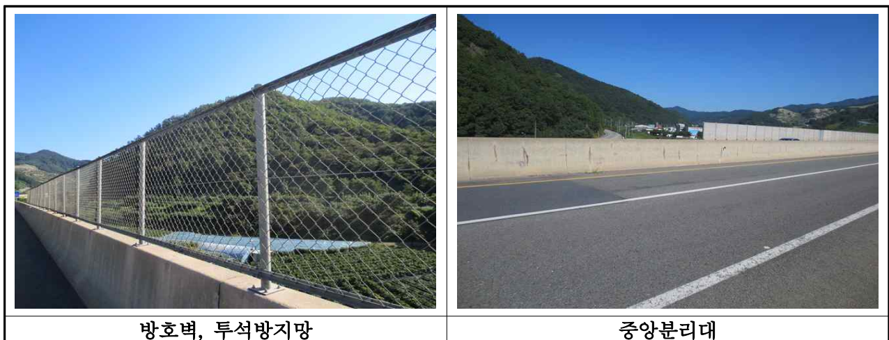
【사진 3.3.23】 난간 및 연석 전경(부산)
