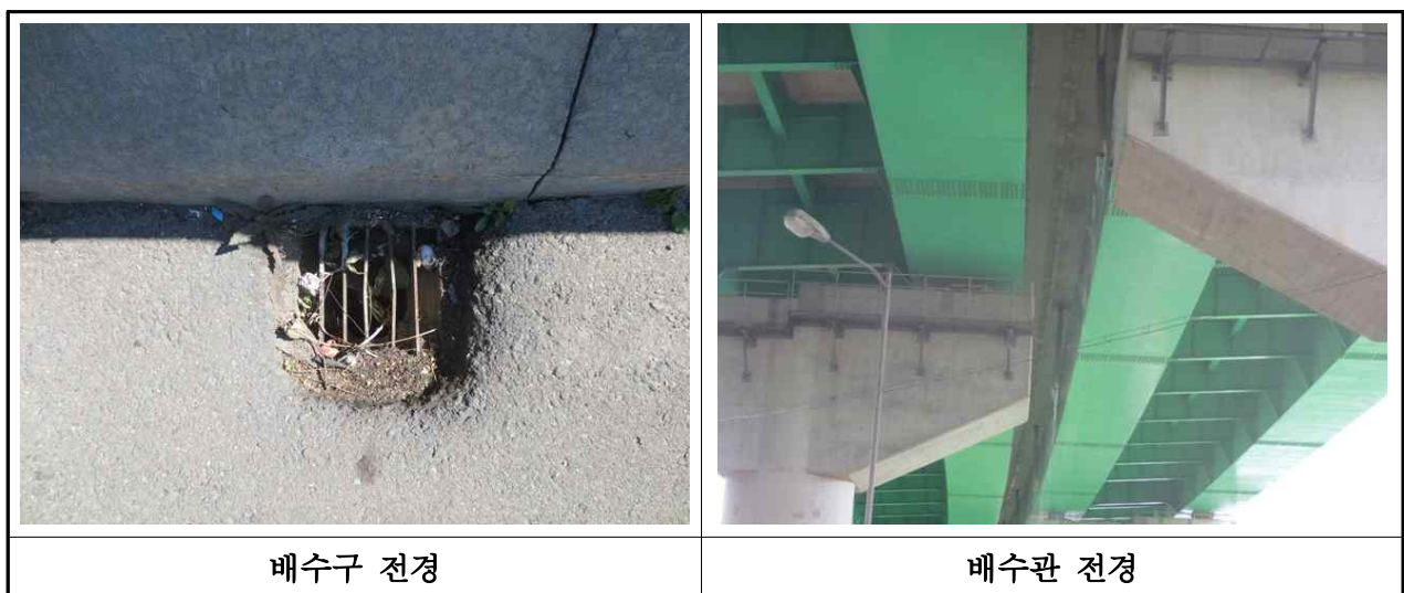
【사진 3.3.21】 배수구 및 배수관 전경(부산)
