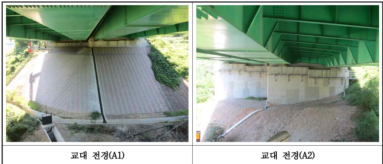
【사진 3.3.8】 교대 전경(부산)
