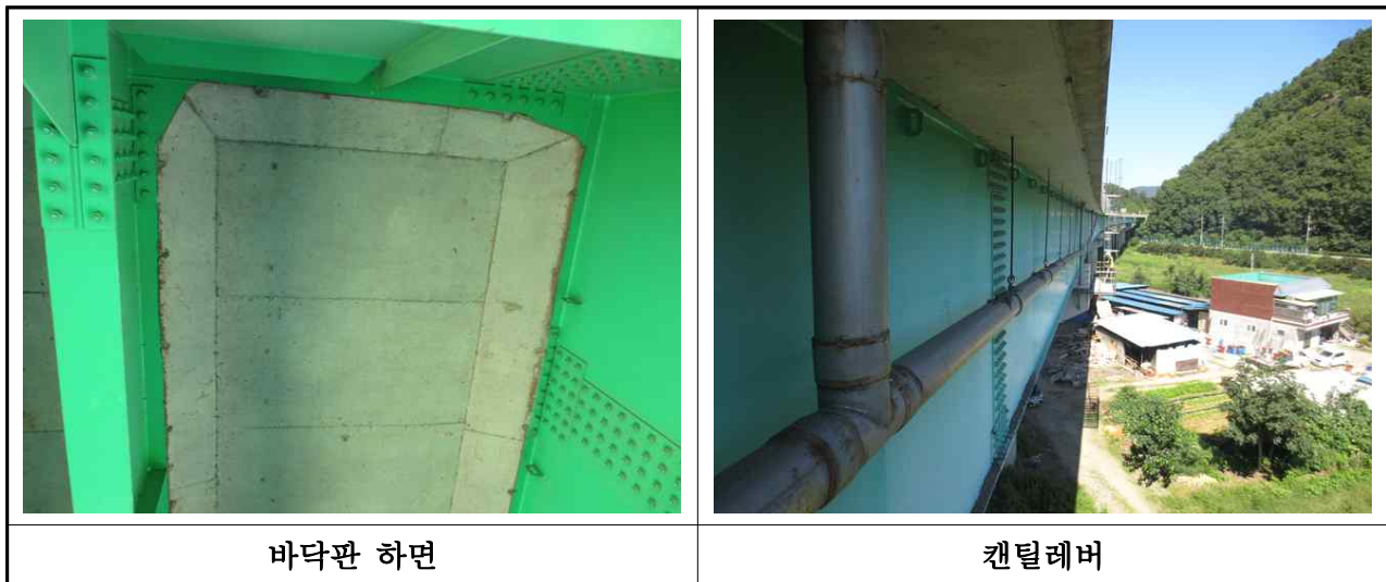
【사진 3.2.1】 바닥판 전경(대구)
