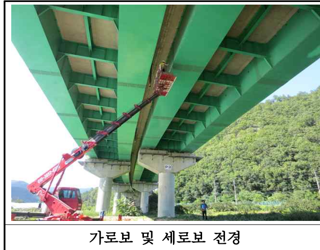
【사진 3.3.6】 가로보 및 세로보 전경(부산)
