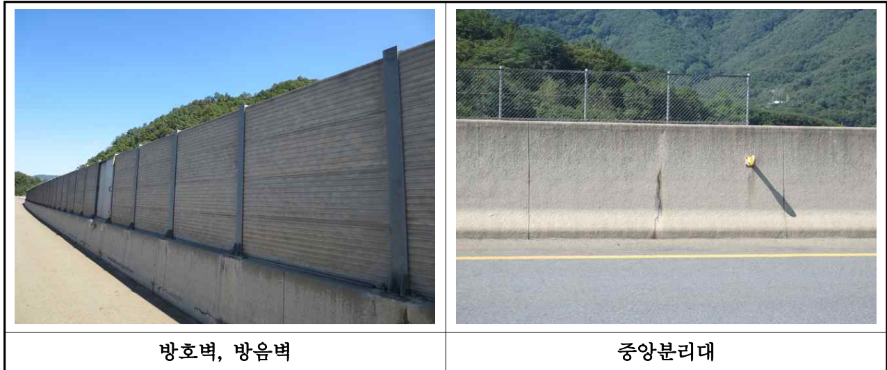
【사진 3.2.23】 난간 및 연석 전경(대구)
