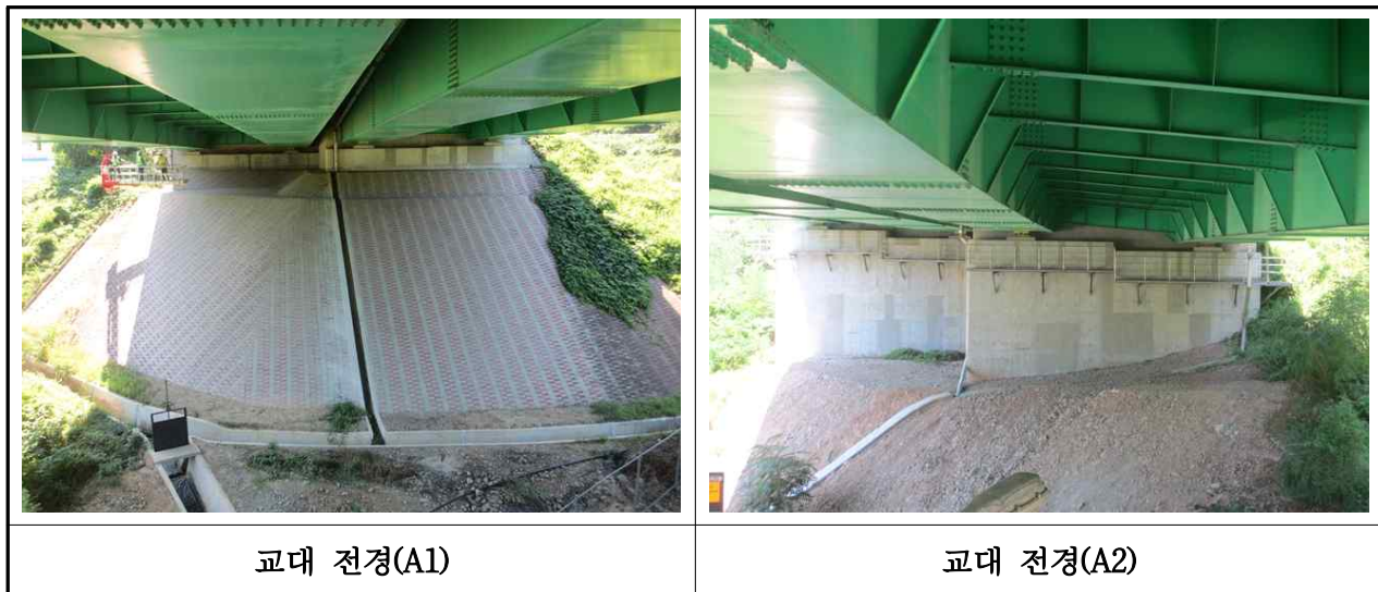
【사진 3.2.8】 교대 전경(대구)
