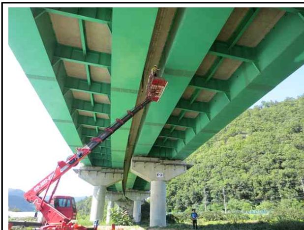
고소작업차를 이용한 조사
