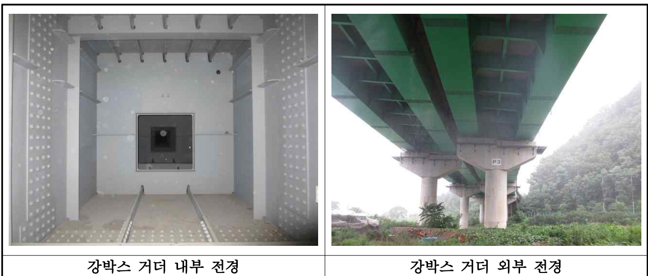
【사진 3.2.3】 강박스 거더 전경(대구)
