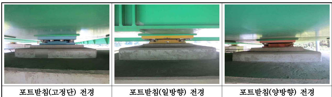
【사진 3.2.13】 교량받침 전경(대구)
