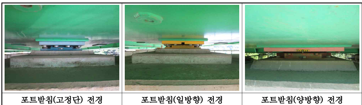
【사진 3.3.13】 교량받침 전경(부산)
